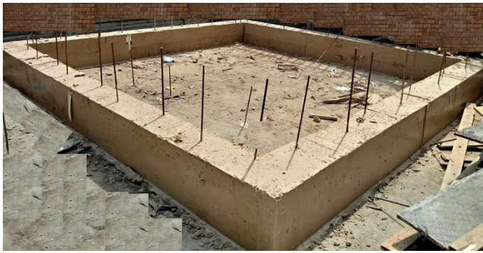
Rys. 12. Fundament z betonu geopolimerowego
